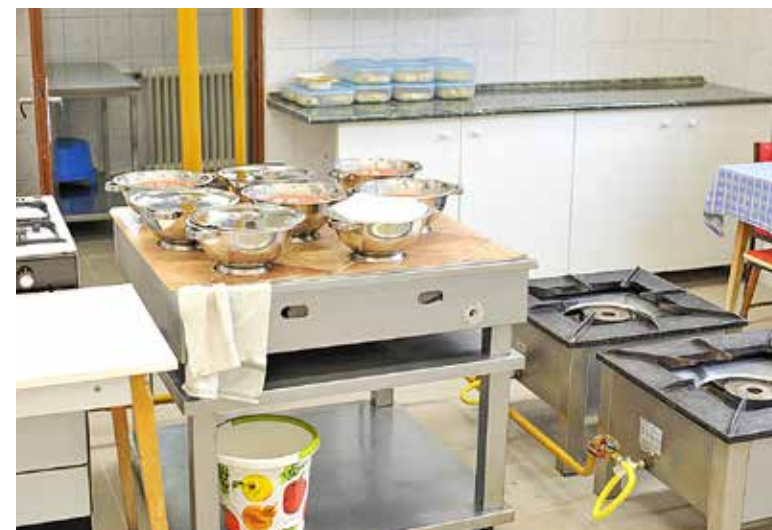
Teljesen átépítették a bölcsőde konyháját
