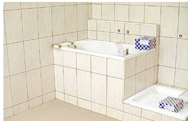
Két vizesblokkot is teljesen felújítottak
